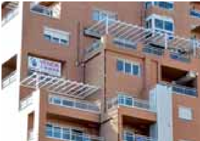
Las nuevas medidas contra el ruido afectarán a todos los elementos constructivos, tabiques, forjados, cubiertas y fachadas.
